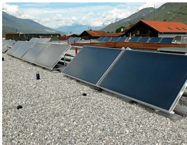
Flachdach-Montage
