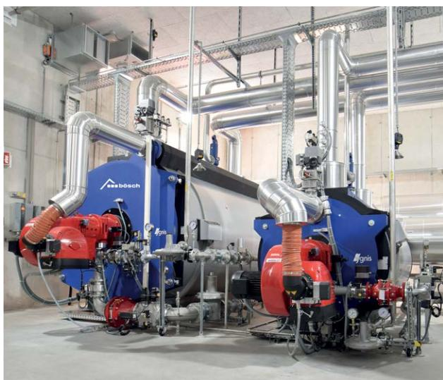
Über die Energiezentrale der Firma Loacker Recycling wird die Nahwärme der Marktgemeinde Hard mit Wärme versorgt. Ein Teil der produzierten Wärme wird auch zum Heizen der Verwaltung und als Prozesswärme, z.B. für die Bioabfallvergärungsanlage verwendet. Die Wärme wird von zwei Weishaupt Brennern produziert und über die Pufferspeicher gehalten und kontrolliert abgegeben.
