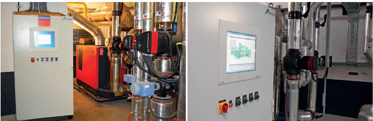
Zwei bösch Gas-Kessel 310/680-Pro sorgen für angenehme Arbeitstemperaturen bei IMA SCHELLING.
