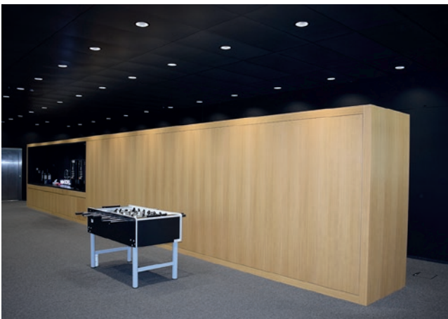
Im Pausenraum des Neubaus sieht man die Kühl- und Heizdecke besonders gut.
