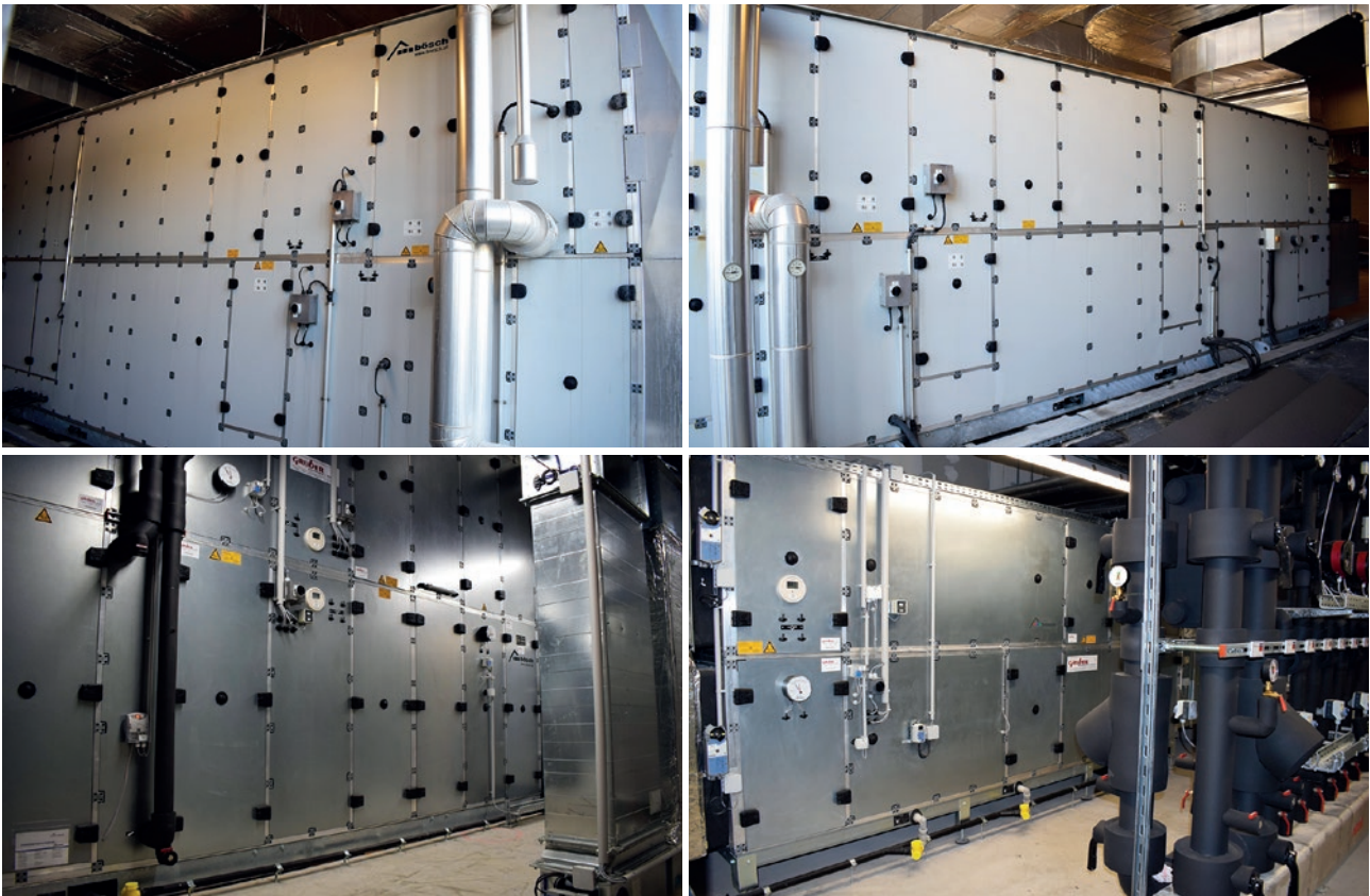
Die vier Lüftungsanlagen versorgen das gesamte Firmengebäude mit Frischluft. Jeweils eine ist zuständig für den Montagebereich, Büro und Ausstellungsräume.
