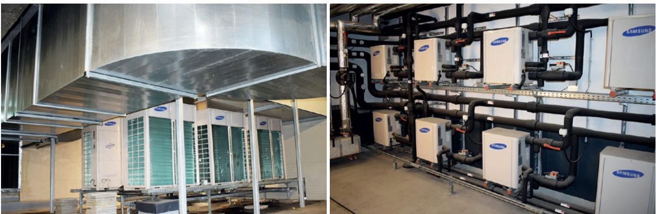
Die sechs Samsung (DVM) Außeneinheiten und die acht Samsung Inneneinheiten sind für die Klimatisierung in einzelnen Bereichen der Firma IMA SCHELLING zuständig.
