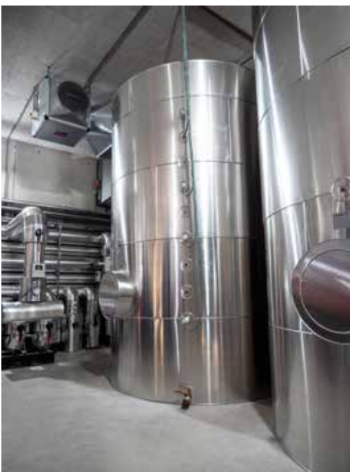
Weichenpuffer und Laufzeitpuffer zum Speichern der Wärme.
