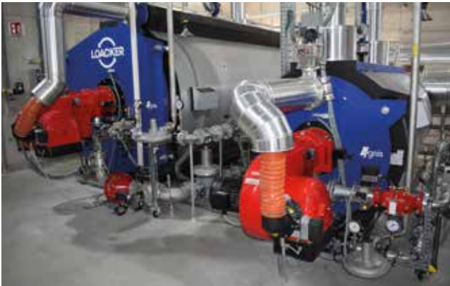
Die zwei Weishaupt-Brenner WM-G 30, die mit Erdgas und/oder Biogas befeuert werden und Ygnis Kessel zur Erzeugung von Wärme: beides aus dem Hause bösch.
