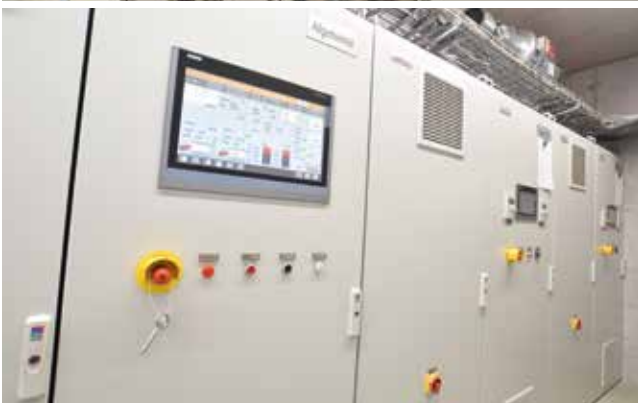
Die innovative bösch Regelung für Mehrkesselanlagen (Mehrkesselregelung [MKR]) mit großem Touch-Display.
