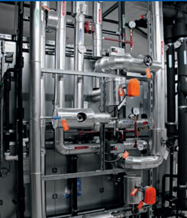
Das RLT-Gerät für die endoskopische Abteilung mit den Befeuchterlanzen für Hausdampf.
