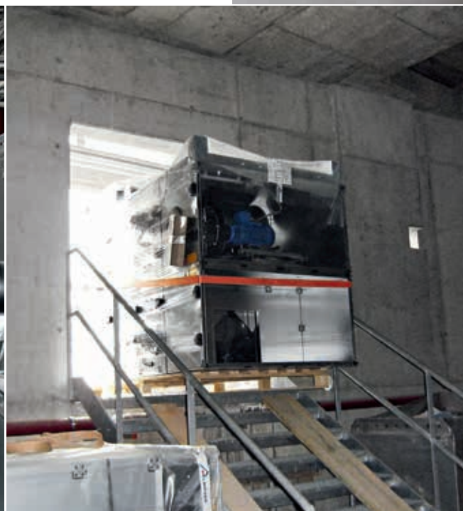
Durch Kubenteilung der Geräte konnte die schwierige Einbringungssituation gelöst werden.
