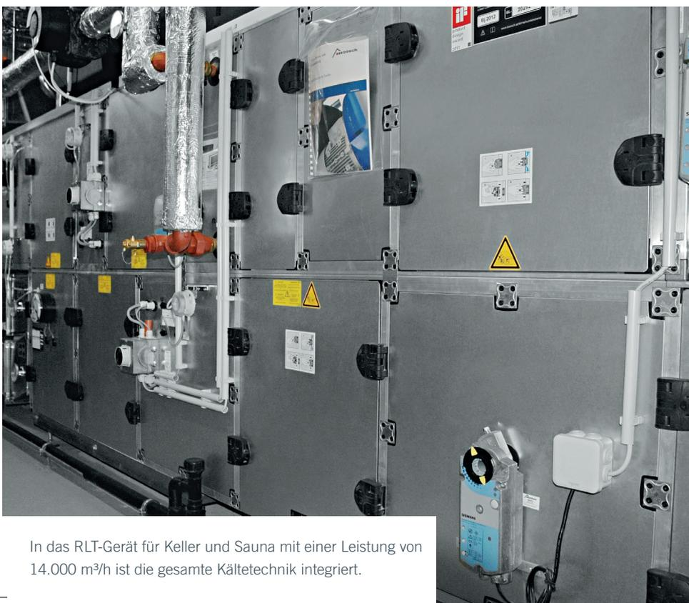
In das RLT-Gerät für Keller und Sauna mit einer Leistung von 14.000 m<sup>3</sup>/h ist die gesamte Kältetechnik integriert.
