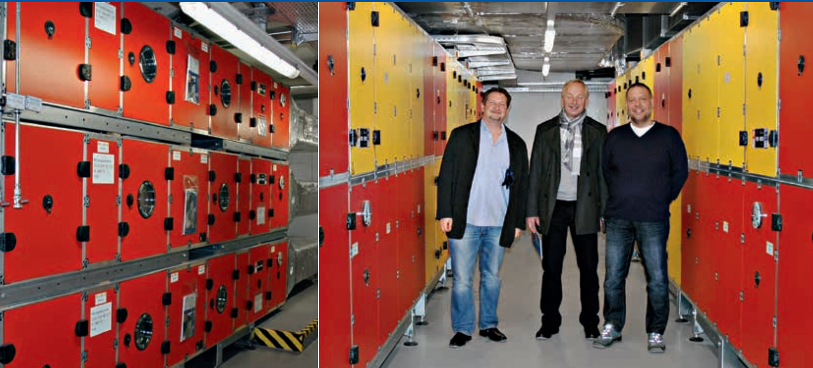
Die farbliche Kennzeichnung der Geräte erleichtert den Wartungsdienst (rot = Zuluft, gelb = Abluft).
