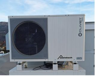
Präzise Installation: Per Kran wurde die HLK-Anlage behutsam auf das Dach gehoben. Die angebaute Luft-Wasser-Wärmepumpe wird mit dem natürlichen Kältemittel Propan (R290) betrieben – eines der umweltfreundlichsten am Markt.
