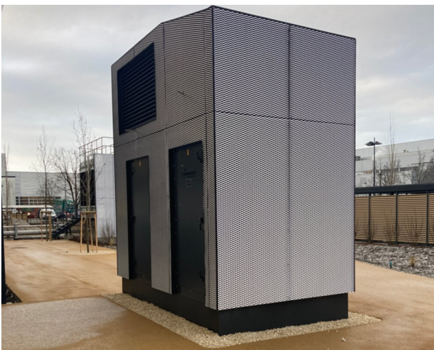
Im Außenluft-Fortluft-Turm wird die Luft bereits gefiltert, bevor sie durch das Kanalnetz strömt. Der Außenluft-Fortluft-Turm: Eine Sonderkonstruktion speziell entwickelt, die individuellen Kundenanforderungen zu erfüllen.
