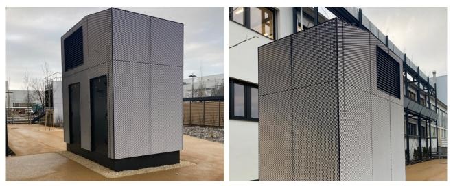
Im Außenluft-Fortluft-Turm wird die Luft bereits gefiltert, bevor sie durch das Kanalnetz strömt. Der Außenluft-Fortluft-Turm: Eine Sonderkonstruktion speziell entwickelt, die individuellen Kundenanforderungen zu erfüllen.
