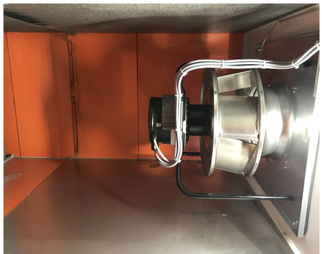
Alt (links) versus Neu (rechts): Seit 2022 sorgen hocheffiziente EC-Ventilatoren für einen energiesparenden Betrieb der Lüftungszentrale.
