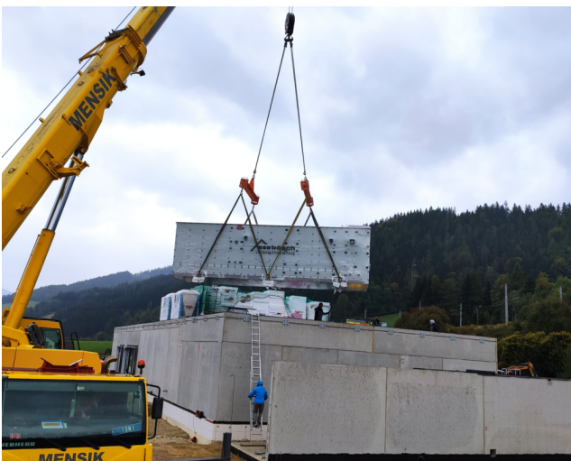
Die All-in-one Kompaktlüftungsanlage von bösch beim Verhub auf das Dach des neuen McDonald's in Spital am Semmering. Günther Kurz (bösch Projektverkauf) mit Johann Unger (bösch Projekttechniker) bei der Einweisung und Anlagenübergabe.
