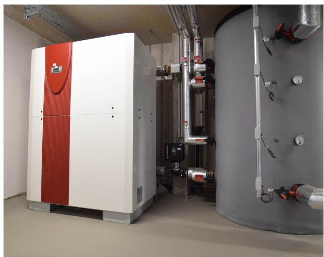
Linkes Bild: Bildschirmoberfläche der Gebäudeleittechnik. Rechtes Bild: Sole/Wasser Wärmepumpenanlage 73,5 kW – effizient, sparsam, umweltfreundlich.
