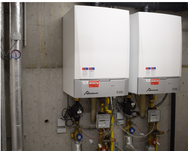
Linkes Bild: Zwei Gas-Brennwert-Heizzentralen à 65 kW zur Spitzenlastabdeckung. Rechtes Bild: Jeweils ein Lüftungsgerät ist zuständig für die Räumlichkeiten im Ober- & Untergeschoß, die Küche, die Schulungsräume, das Lager und die Nebenräume.
