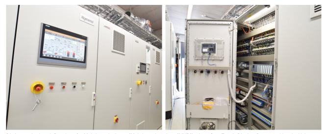
Die innovative bösch Regelung für Mehrkesselanlagen (Mehrkesselregelung [MKR]) mit großem Touch-Display. Das ausgeklügelte Volumenstrom-Management kann bei Einzel- und Folgebetrieb ökologisch vorteilhafte Erzeuger maximal auslasten.
