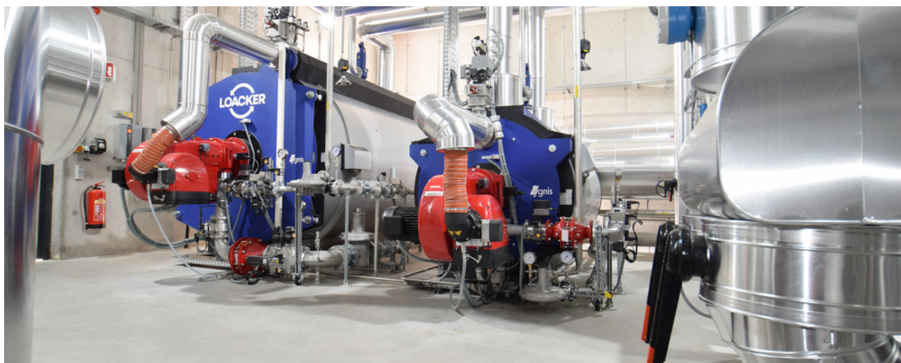
Die zwei Weishaupt-Brenner WM-G 30, die mit Erdgas und/oder Biogas befeuert werden und Ygnis Kessel zur Erzeugung von Wärme: beides aus dem Hause bösch.
