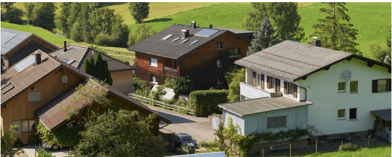
Zwei bestehende Solaranlagen (eine auf dem Dach, die andere im Vorgarten) wurden in das neue Heizsystem eingebunden.
