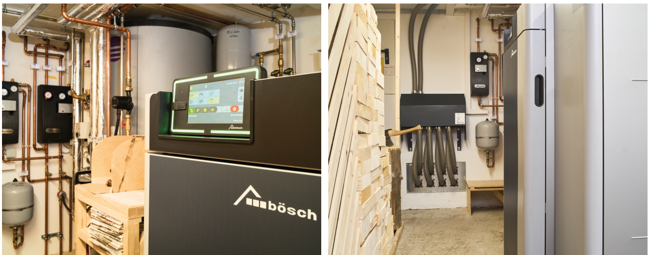
Die bösch Kombi-Heizzentrale DUO vereint die Vorteile von Stückholz und Pellets in einer Anlage. Der Kessel kann wahlweise auch mit Scheitholz betrieben werden.
