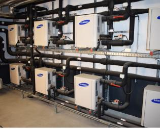
Jeweils eine Lüftungsanlage ist zuständig für den Montagebereich, Büro und Ausstellungsräume. Die acht Samsung Inneneinheiten sind für die Klimatisierung in einzelnen Bereichen der Firma IMA SCHELLING zuständig.
