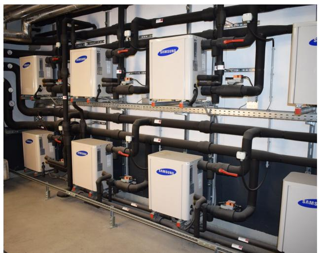
Jeweils eine Lüftungsanlage ist zuständig für den Montagebereich, Büro und Ausstellungsräume. Die acht Samsung Inneneinheiten sind für die Klimatisierung in einzelnen Bereichen der Firma IMA SCHELLING zuständig.
