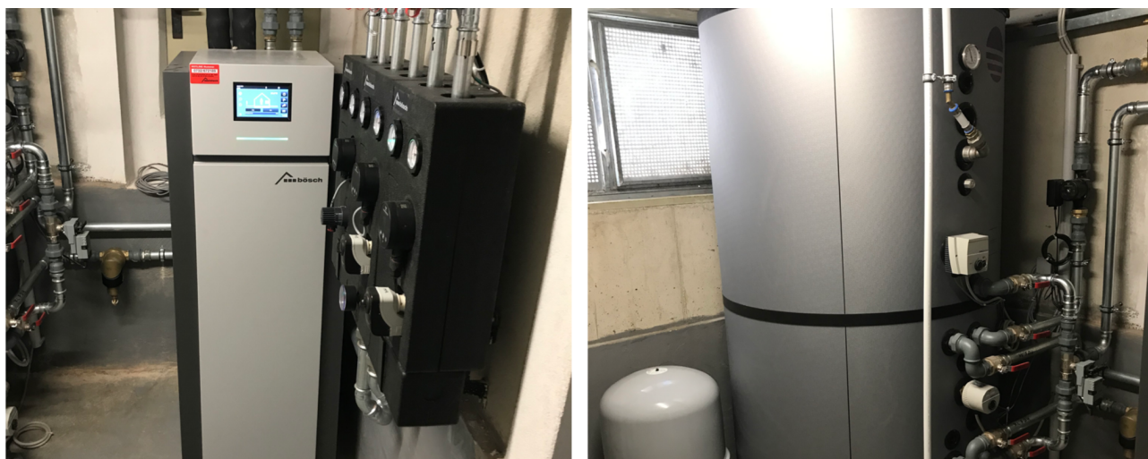
Linkes Bild: Die modulierende Sole/Wasser-Wärmepumpe KLIMT. Rechtes Bild: Der Systemspeicher EMMA mit integriertem Edelstahl-Wellrohrregister für hygienische TWW-Bereitung und optimales Wärmemanagement.
