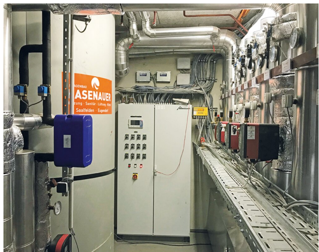
Rechts: Einer von vier Schaltschränken für den Wellnessbereich für den Niederhof im Genussdorf Gmachl.
