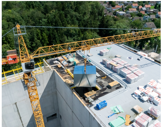
Linkes Bild: Der Verhub der Kuben mit einem Kran direkt durch das Dach in den obersten Stock. Rechtes Bild: Millimeterarbeit.
