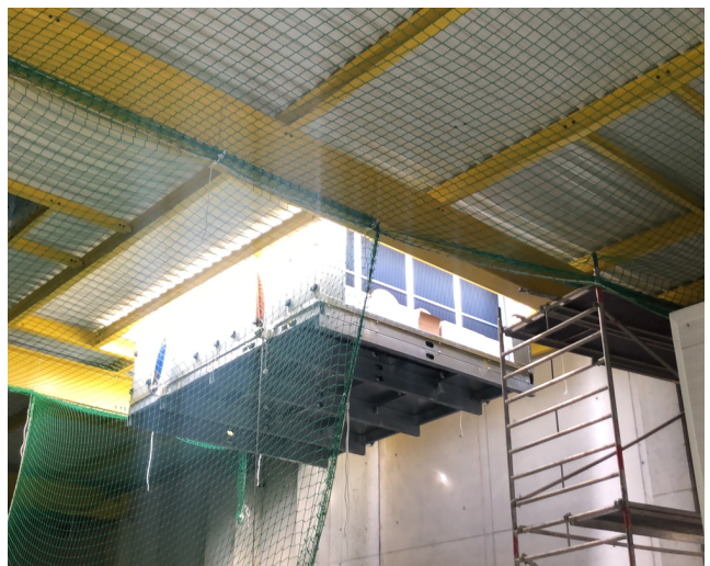
Linkes Bild: Der Verhub der Kuben mit einem Kran direkt durch das Dach in den obersten Stock. Rechtes Bild: Millimeterarbeit - dieses Mal von innen betrachtet.
