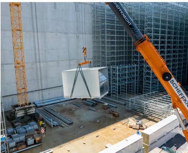
Linkes Bild: Der Verhub der Kuben mit einem Kran direkt durch das Dach in den obersten Stock. Rechtes Bild: Millimeterarbeit - dieses Mal von innen betrachtet.
