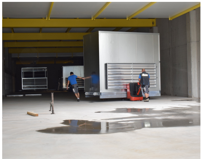
Linkes Bild: Gleich ist es geschafft und das Gerät ist heio durch die Decke. Rechtes Bild: Nach dem Verhub werden die Kuben an die richtige Position transportiert und montiert.
