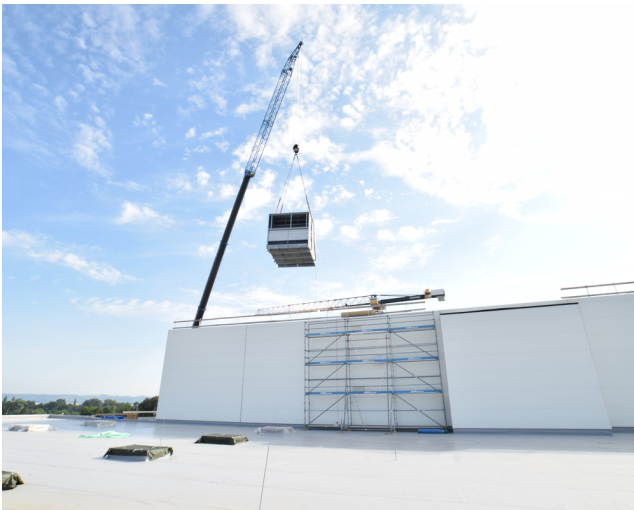
Linkes Bild: Der Verhub der Kuben mit einem Kran direkt durch das Dach in den obersten Stock. Rechtes Bild: Millimeterarbeit.
