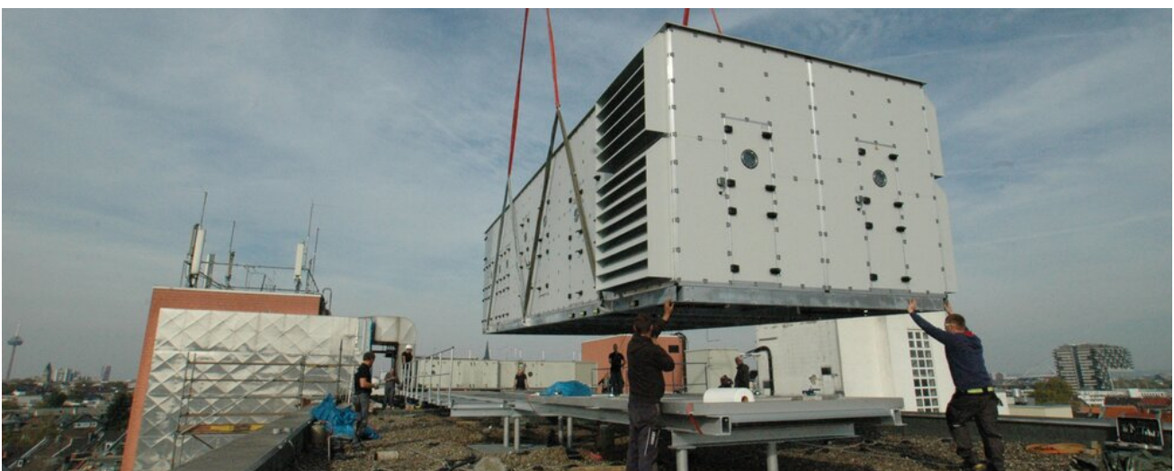
Das Lüftungsgerät wurde mittels Kran an seinen Bestimmungsort am Dach des Krankenhauses gehievt.
