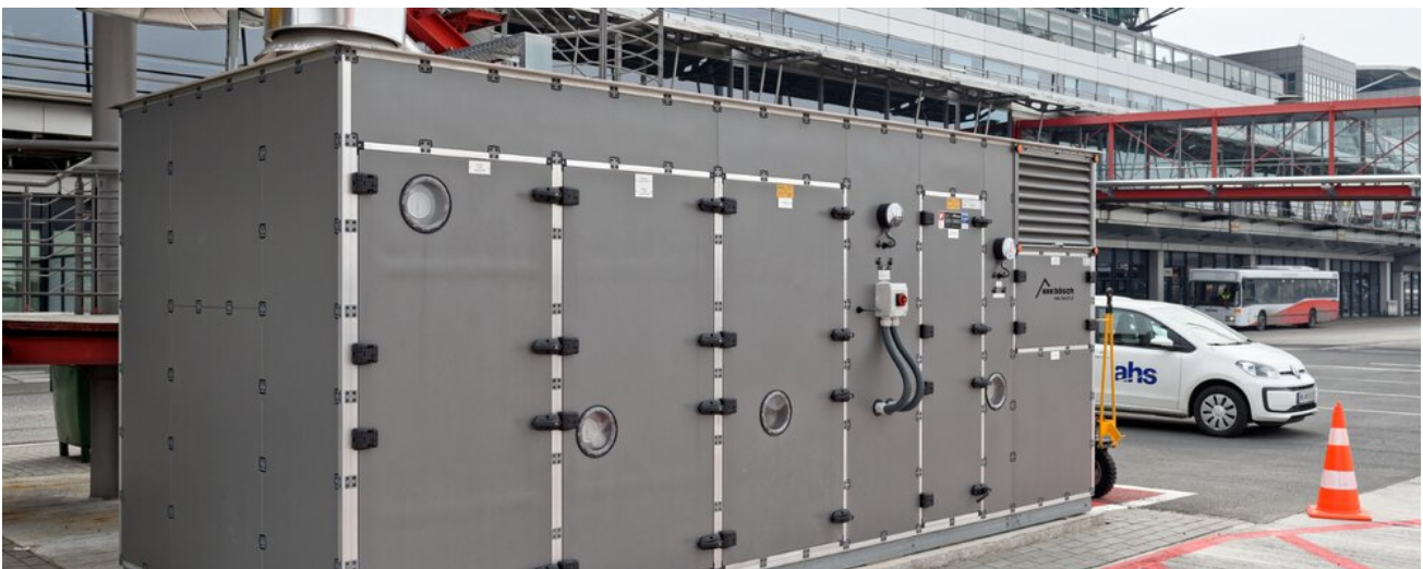
15 PCA-Geräte von bösch sorgen auf dem Hauptvorfeld für die effiziente und geräuscharme Belüftung der Flugzeugkabinen.
