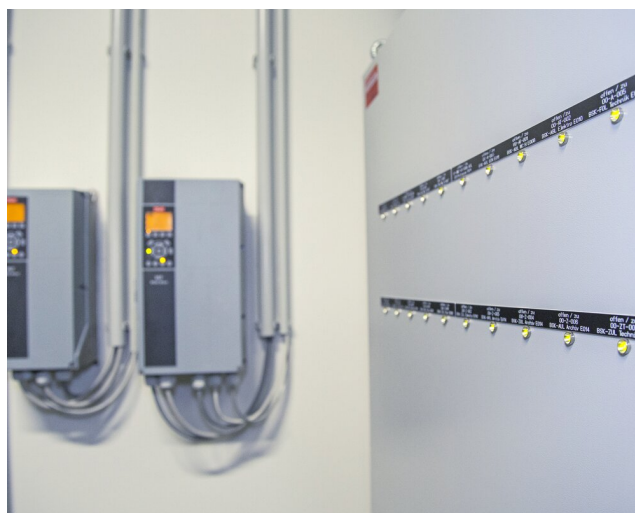
Schaltschrank mit DEOS OPENweb-Regelung. Moderne Regelungstechnik von bösch im prämierten Blue Building von Peter Blau.
