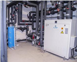
Das vierstöckige Lüftungsgerät der Type modul a M2,0 überzeugt mit hohen WRG-Werten (RWZ 63 %, RFZ 63 %). Die Wärmepumpe von bösch sorgt mit einer Heizleistung von 80 kW und einer Kälteleistung von 60 kW für ein optimales Klima.
