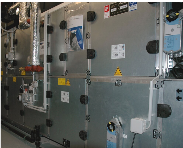
Linkes Bild: In das RLT-Gerät für Keller und Sauna mit einer Leistung von 14.000 m 3 /h ist die gesamte Kältetechnik integriert. Rechtes Bild: Der zentral gelegene Schaltschrank wird vom Hausverwalter bedient, der die einfache Handhabung lobt.
