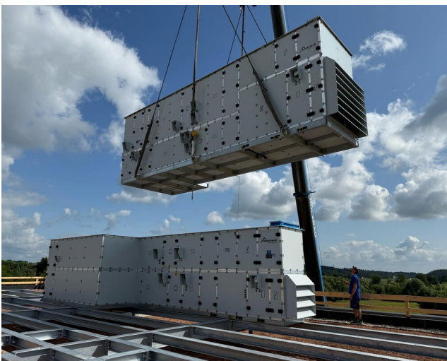
Montage auf dem Dach: Die Lüftungsgeräte wurden per Kran auf die vorbereiteten Aufstellflächen gehoben und dort positioniert.
