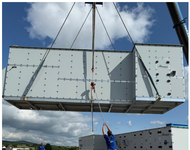
Montage auf dem Dach: Die Lüftungsgeräte wurden per Kran auf die vorbereiteten Aufstellflächen gehoben und dort positioniert.
