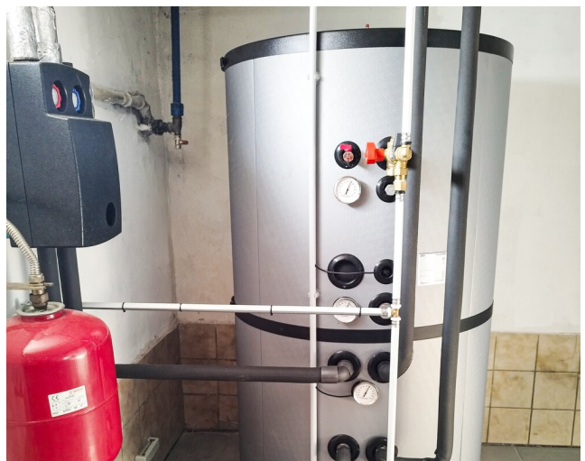
Die beiden Heizkreise verteilen die Wärme bedarfsgerecht im gesamten Haus. (li) Der EMMA-Systemspeicher bindet die bestehende Solaranlage ein und unterstützt die gleichmäßige Wärmeversorgung im Haus. (re)
