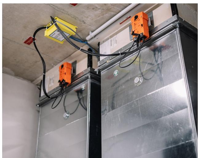
Bild links: Die moderne Regelung von bösch steuert alle Lüftungs- und Kälteanlagen präzise und bedarfsgerecht – das sorgt für gleichbleibend hohen Komfort bei minimalem Energieverbrauch. Bild rechts: Die Brandfallsteuerung von AGNOSYS ist nahtlos in die Gebäudeautomation eingebunden und steuert im Ereignisfall die Brandschutz- und Entrauchungsklappen zuverlässig und koordiniert.
