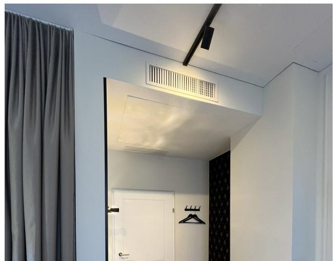
Kompakte Fancoils arbeiten leise und fügen sich harmonisch in die historischen Zimmer ein. Kanaleinbaugeräte in den unteren Geschossen: gleichmäßige Luftverteilung bei minimalem Eingriff in die Raumgestaltung.
