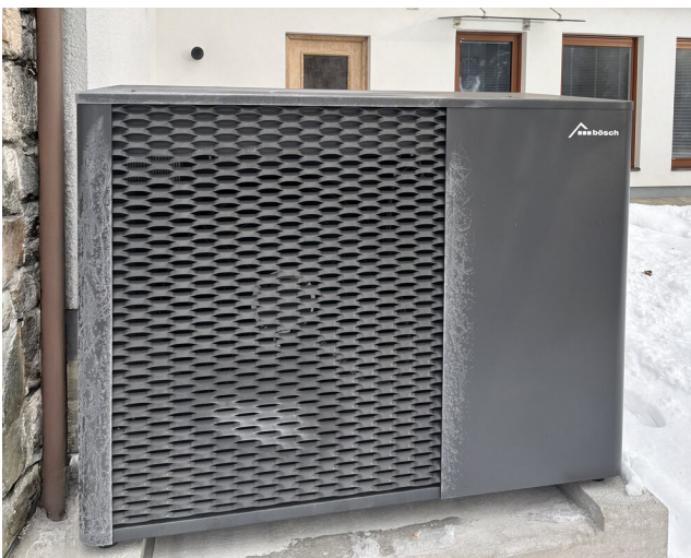
Bild links: Luft-Wasser-Wärmepumpe MOZART R290: Effiziente Wärme auch bei tiefen Außentemperaturen. Bild rechts: Sauber ausgeführt von Wieser & Scherer: Wärmepumpenmanager und die gesamte Hydraulik.
