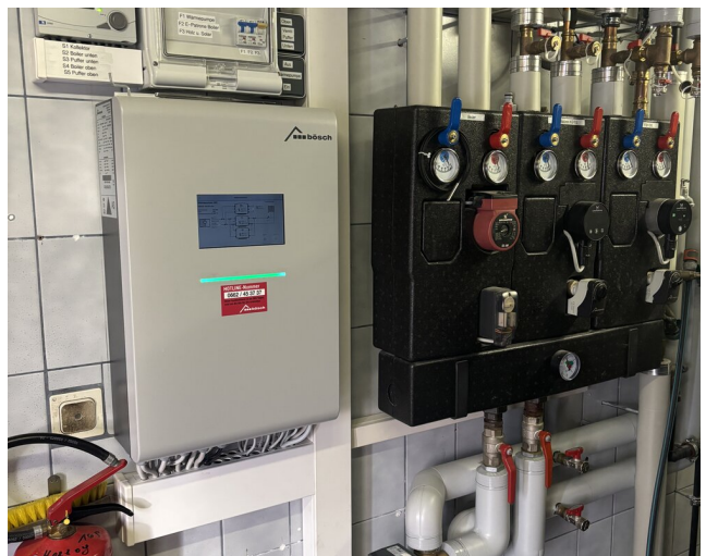
Bild links: Luft-Wasser-Wärmepumpe MOZART R290: Effiziente Wärme auch bei tiefen Außentemperaturen. Bild rechts: Sauber ausgeführt von Wieser & Scherer: Wärmepumpenmanager und die gesamte Hydraulik.
