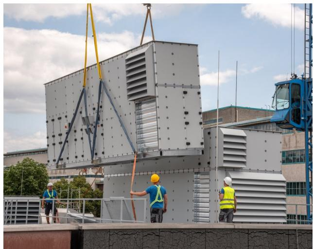
Via Sondertransport wurden die beiden Kuben von Lustenau/Vorarlberg nach Linz transportiert. Am Aufstellungsort: Der erste Kubus ist bereits an Ort und Stelle - der zweite Teil wird passgenau via Kran positioniert und dann vom bösch Montageteam installiert.
