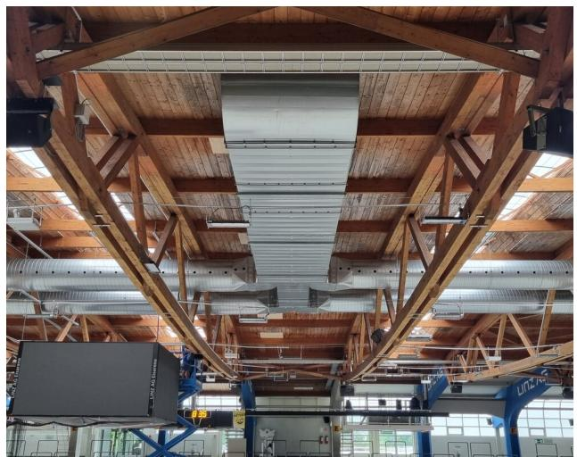
Das fertig montierte Eishallen-Entfeuchtungsgerät auf dem Dach: Zuluft 30.000 m<sup>3</sup>/h, Abluft 27.000 m<sup>3</sup>/h, Regeneration 12.000 m<sup>3</sup>/h. Verteilung der aufbereiteten Luft entlang der Holzbinder, angebunden an das Lüftungsgerät von bösch.
