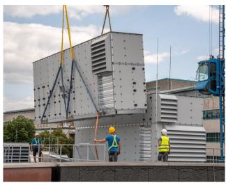
Via Sondertransport wurden die beiden Kuben von Lustenau/Vorarlberg nach Linz transportiert. Am Aufstellungsort: Der erste Kubus ist bereits an Ort und Stelle - der zweite Teil wird passgenau via Kran positioniert und dann vom bösch Montageteam installiert.
