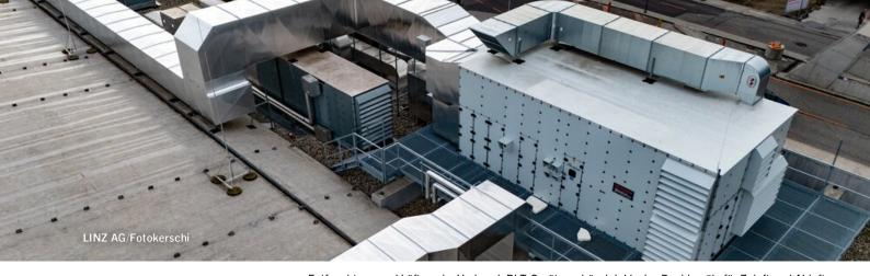
Entfeuchtung und Lüftung im Verbund: RLT-Gerät von bösch inklusive Dachkanäle für Zuluft und Abluft.
