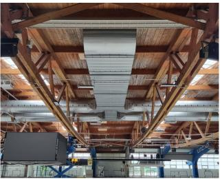
Das fertig montierte Eishallen-Entfeuchtungsgerät auf dem Dach: Zuluft 30.000 m³/h, Abluft 27.000 m³/h, Regeneration 12.000 m³/h. Verteilung der aufbereiteten Luft entlang der Holzbinder, angebunden an das Lüftungsgerät von bösch.
