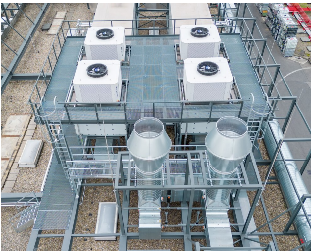
Adiabate Kühleinheiten aus der Vogelperspektive
