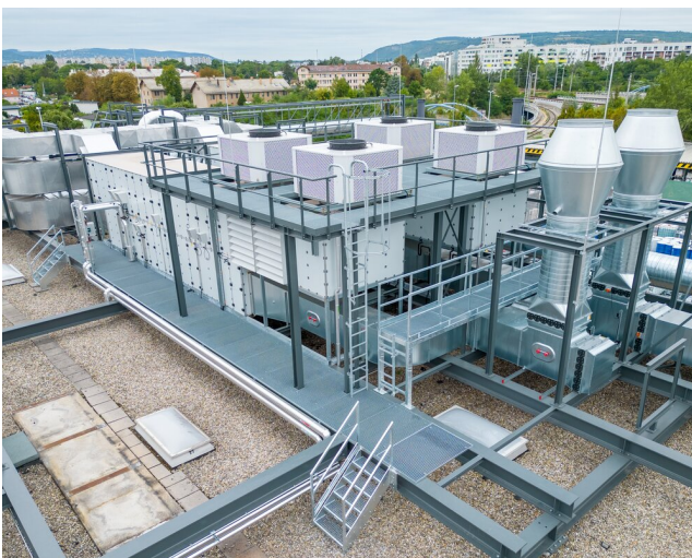
Die neue adiabate Kühlung am Dach von Kansai Helios
