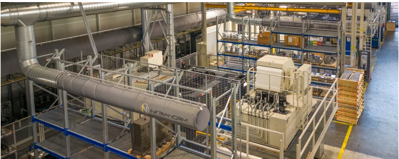
Die Lufteinbringung erfolgt zielgerichtet in Zonen mit den individuell gefertigten Textilluftauslässen
