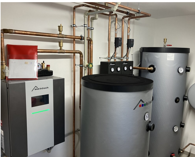
Linkes Bild: Im Heizraum: die komplette bösch Systemlösung mit Hydrobox, Pufferspeicher, Warmwasserspeicher und handgelöteten Kupferrohren. Rechtes Bild: Puffer- und Warmwasserspeicher von bösch garantieren Komfort und zuverlässige Versorgung
