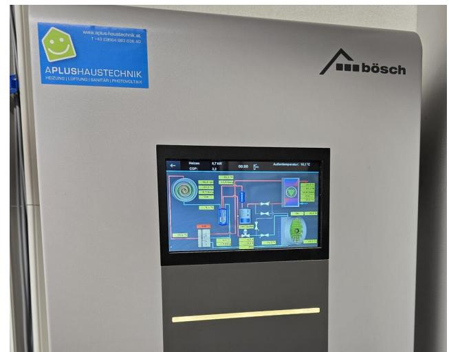
Linkes Bild: Der Lastausgleichspuffer (ganz rechts im Bild) stabilisiert den Anlagenbetrieb, sorgt für gleichmäßige Wärmeverteilung und schützt die Wärmepumpe vor häufigem Takten. Rechtes Bild: Über den Wärmepumpenmanager wird die MOZART Wärmepumpe automatisch geregelt und kann jederzeit kontrolliert werden.
