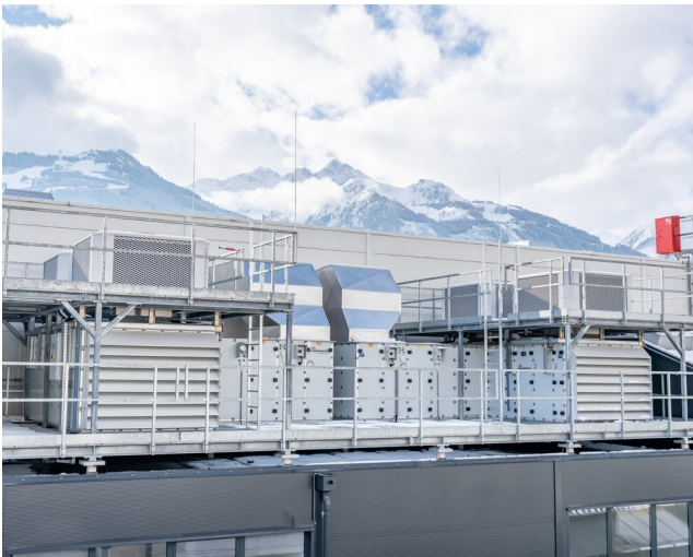
Lüftungsgeräte mit aufgesetzten Kühleinheiten zur Luftkonditionierung
