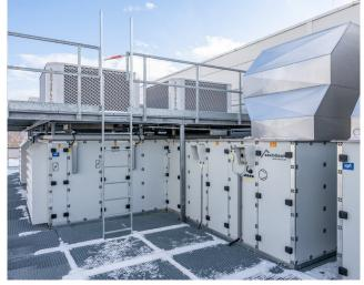
Lüftungsgeräte mit aufgesetzten Kühleinheiten zur Luftkonditionierung
