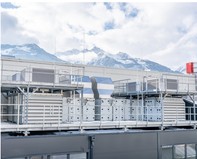
Lüftungsgeräte mit aufgesetzten Kühleinheiten zur Luftkonditionierung
