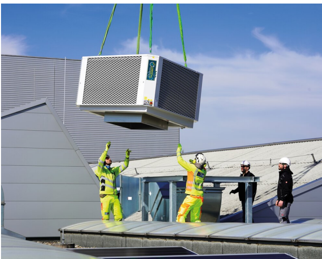
Helikopter-Transport der Elemente zur zentral gelegenen Halle.
