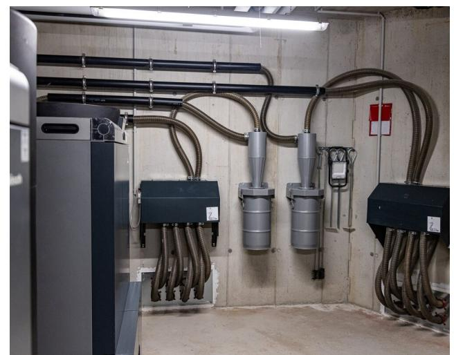
Zwei Pelletsheizkessel mit je 100 kW Heizleistung versorgen das gesamte Hotel-Dorf Zaglgut zuverlässig und klimafreundlich mit Wärme – vollautomatisch und effizient. Das Saugsonden-System sorgt für eine gleichmäßige, staubfreie Befüllung der Pelletsheizung – ein wesentlicher Bestandteil für einen störungsfreien Dauerbetrieb.
