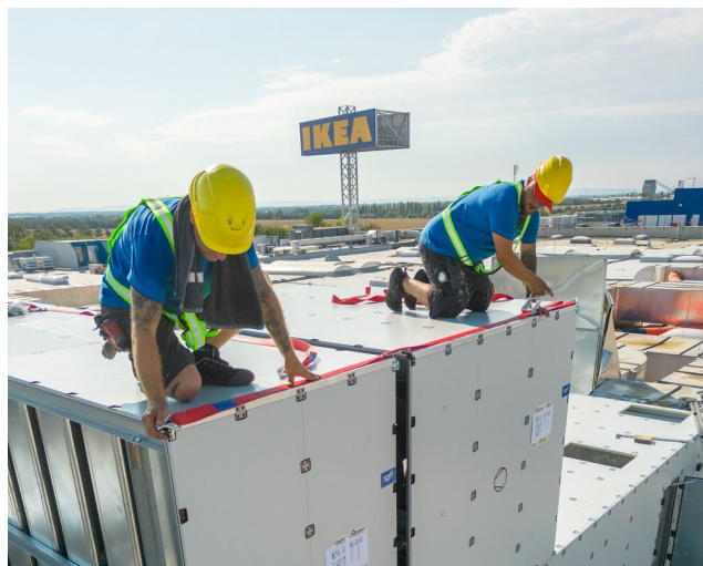
Die insgesamt 61 Kuben wurden via Kran auf das Dach gehoben und direkt am jeweiligen Aufstellungsort platziert.
