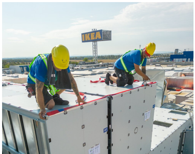
Die insgesamt 61 Kuben wurden via Kran auf das Dach gehoben und direkt am jeweiligen Aufstellungsort platziert.
