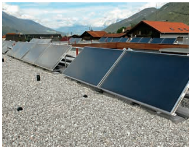
Flachdach-Montage
