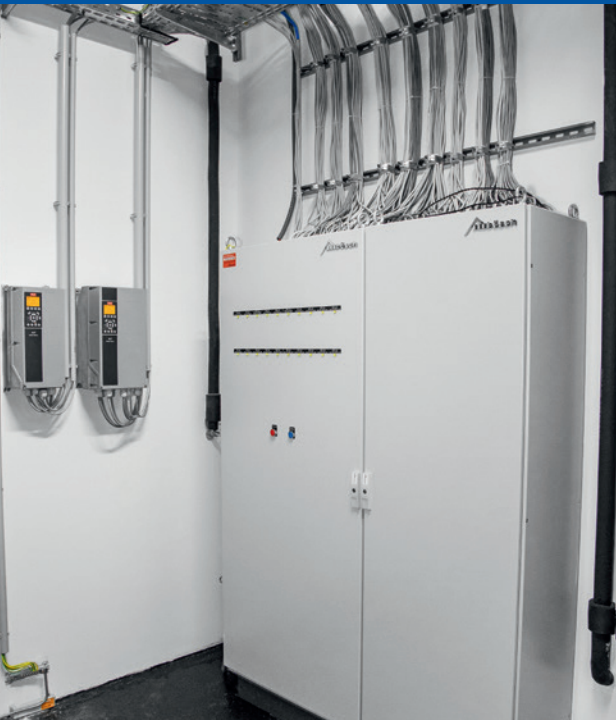
Schaltschrank mit DEOS OPENweb-Regelung.
