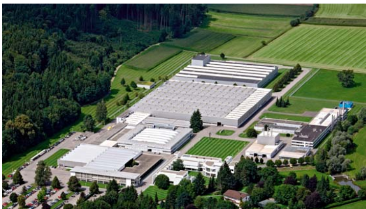
Die Firmenzentrale der Max Weishaupt GmbH in Schwendi.
